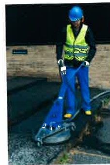
Der Flächenreiniger arbeitet mit bis zu 500 bar Wasserdruck. (Foto: B. Rohnke München)
